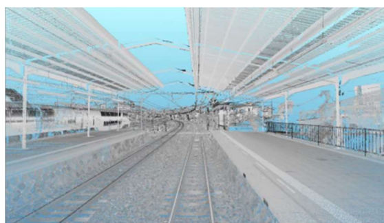
3次元点群データ使用例(伊豆急行線)
